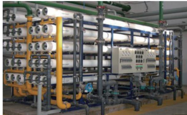
反渗透纯净水设备中设计了一种反渗透膜。膜两侧的压力不同，通过两侧的压力为动力，压迫原水通过反渗透膜，盐的浓度低的会向浓度高的盐方向渗透，能够达到的平衡状态下，就是液体的渗透压。当含有的盐水一侧的压力低于另一侧的渗透压力时候，就会发生反方向的流动，就产生了反渗透过程。
